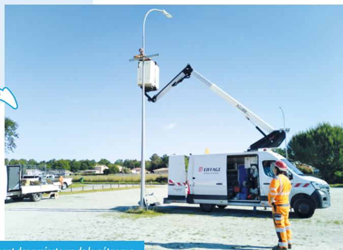
Remplacement des projecteurs de la pétanque
